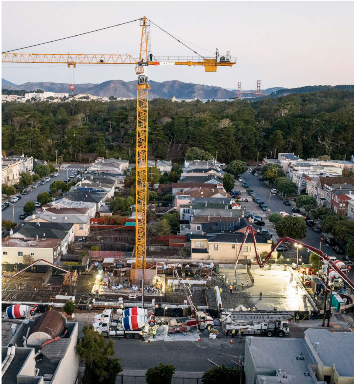
2550 Irving Site Construction
