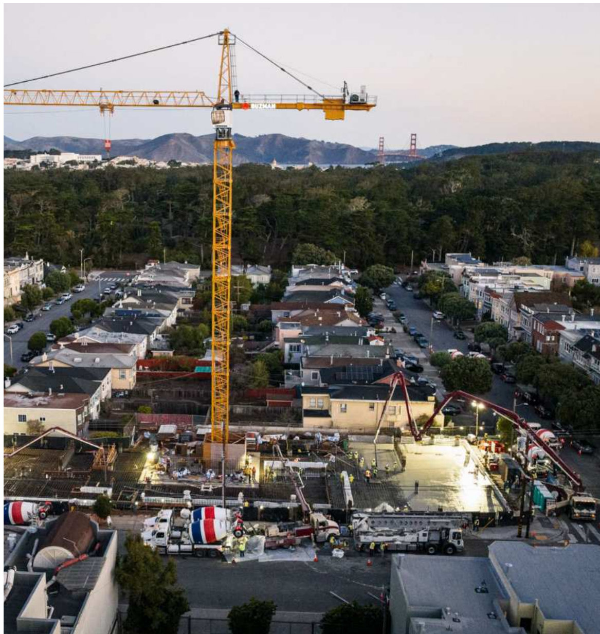
2550 Irving Site Construction
